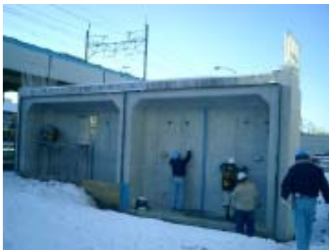
写真 5 測定実施構造物 (橋台)
