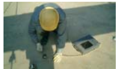
写真4 フーチングでの測定状況
