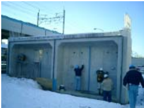
写真 5 測定実施構造物 (橋台)
