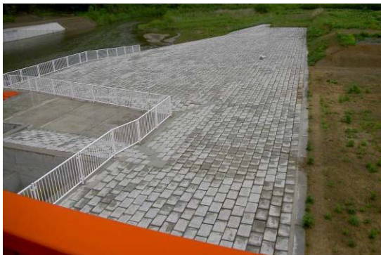
写真-1 護岸ブロック全景
