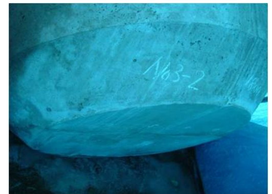
写真6 補修後の品質確認
