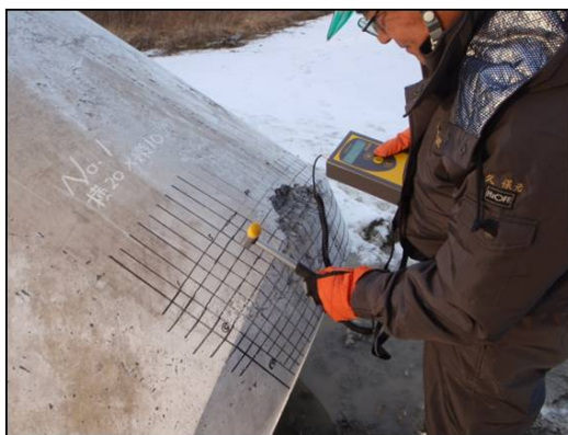
写真4 CTSによる未充填箇所の測定状況
