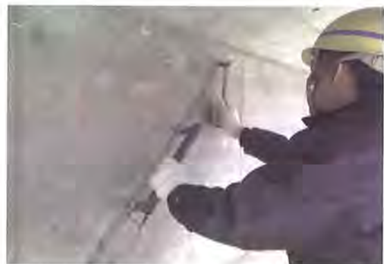
図10 表面2点法による強度測定状況
