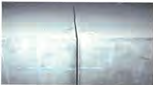
図14 スリット状況
