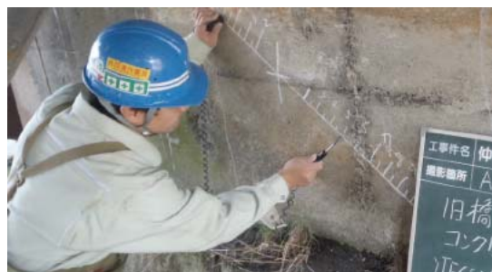
写真-3 衝撃弾性波法による測定状況写真
