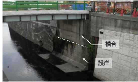
写真-1 測定対象構造物の状況 (A2橋台正面側)
