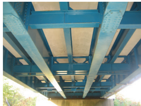
写真-1 下面増厚状況 (A橋)
