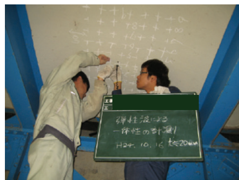
写真-2 剥離状況の測定状況 (B橋)
