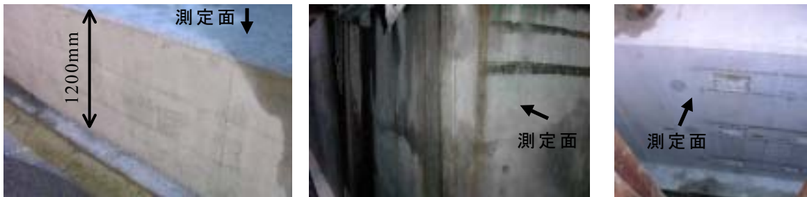
写真-1 現地構造物の状況（左：現場 A、中：現場 B、右：現場 C）
