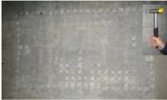
写真-3 トンネル内測定面
