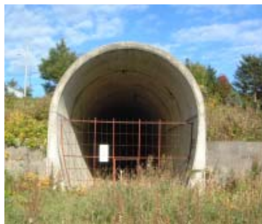
写真-2 旧国鉄トンネル全景
