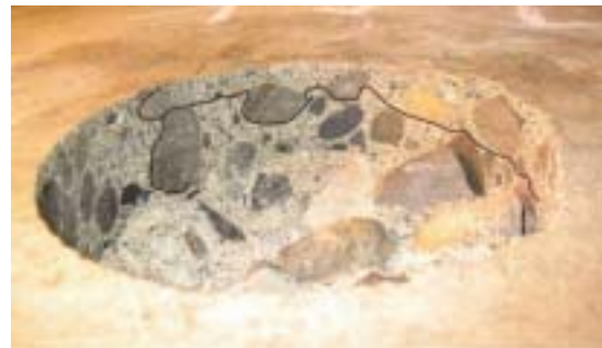
写真-4 コア抜き断面
