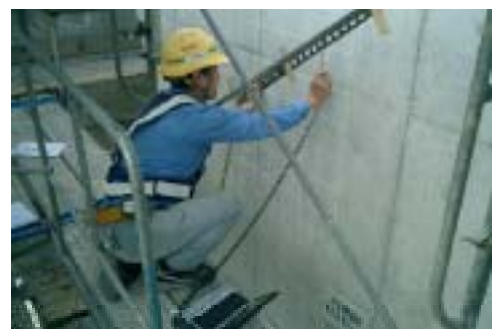
図-8 構造物 B での速度測定状況
