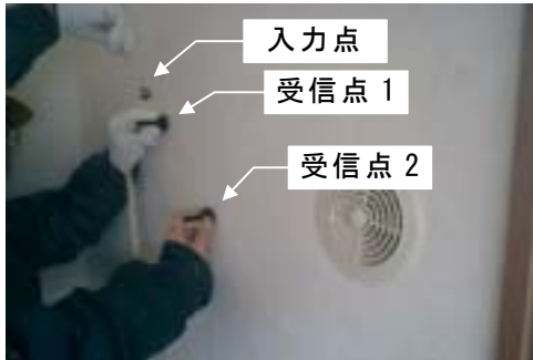
図 1 弾性波速度測定状況
