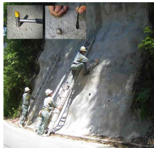
写真-1 現地法面 A 地点の測定風景
