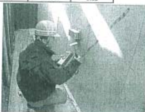
写真 3 構造物 S 測定状況
