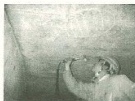
写真4 剥離探査状況
